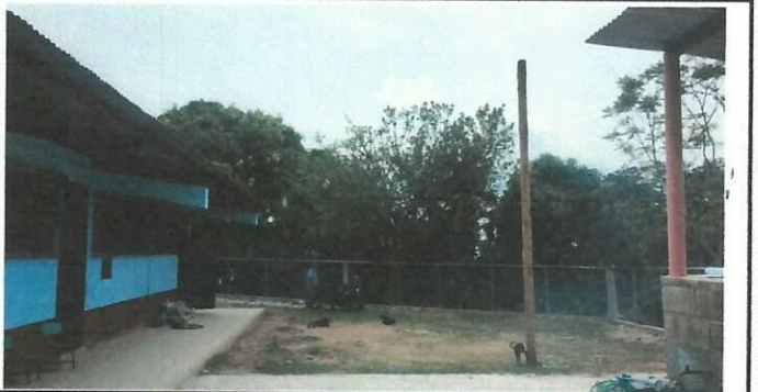
Foto 6: Estructura metálica tipo pórtico mas cubierta de lámina troquelada calibre 26
