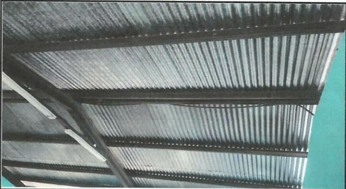
Foto 2: Mejoramiento de cubierta de lámina aula 1
