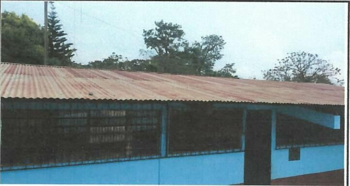
Foto 4: Mejoramiento de cubierta de láminas bodegas
