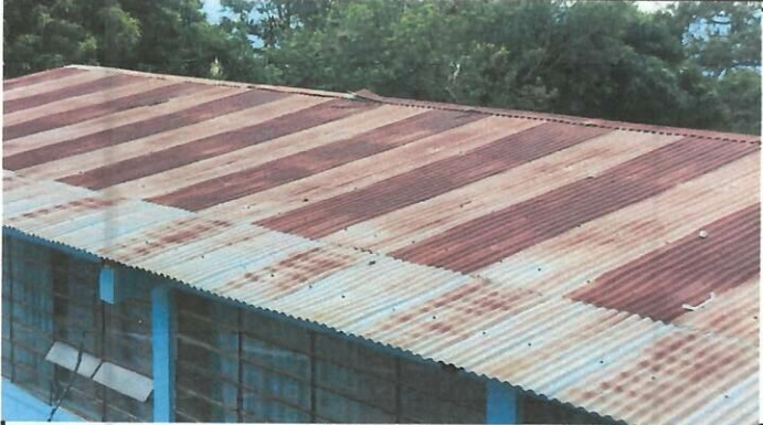
Foto1: Mejoramiento de cubierta de lámina troquelada calibre 16 del establecimiento
